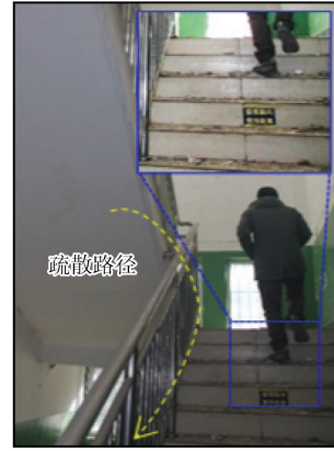
图 24 楼梯疏散受阻示例(柳沟乡, VIII度)
