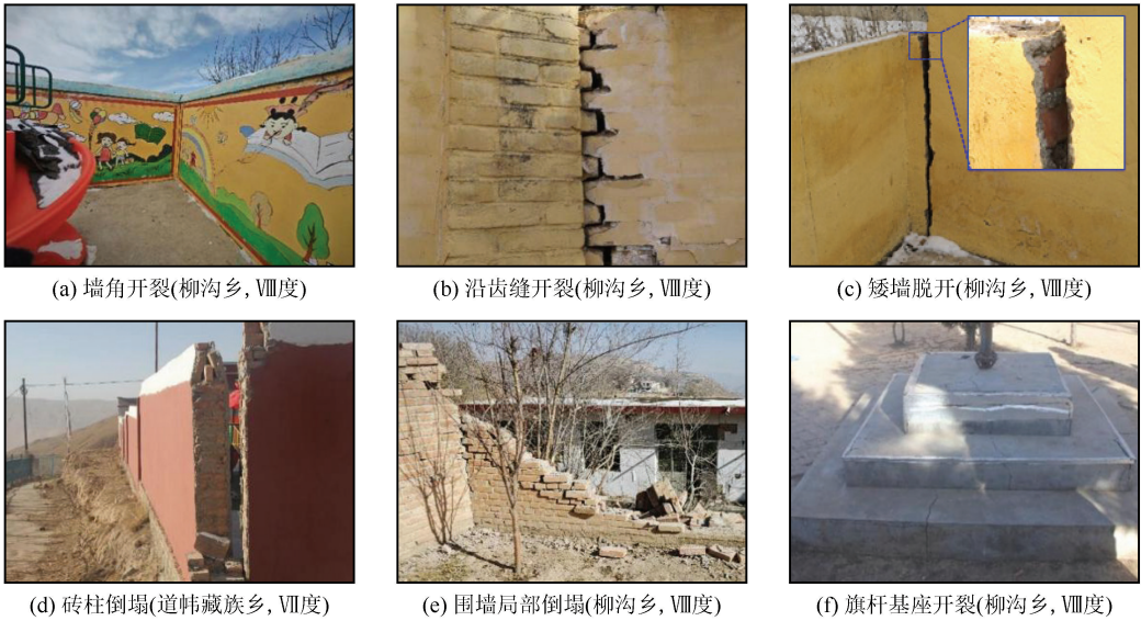
图 20 构筑物震害
