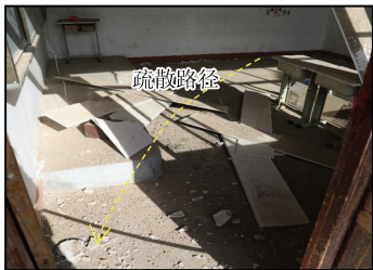
(d) 吊顶坠落(柳沟乡, VIII度)
