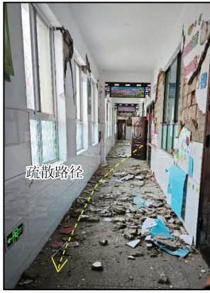
图 23 走廊疏散受阻示例(白庄镇, VI度)
