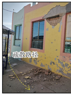
(c) 外墙坠落物 (柳沟乡, VIII度)
