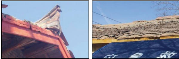
(a) 端头震害(大河家镇, VIII 度) (b) 中部震害(柳沟乡, VIII 度)
