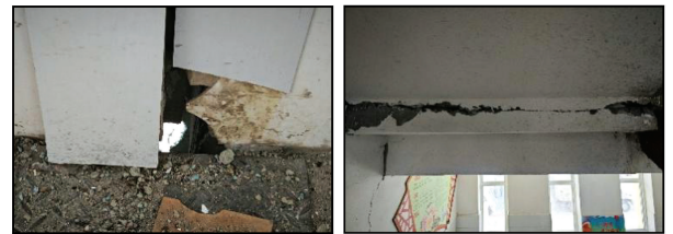
(a) 抗震缝(柳沟乡, VIII 度) (b) 楼梯滑动支座(柳沟乡, VIII 度)
