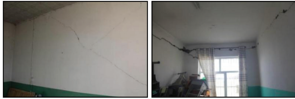
(a) 斜裂缝(柳沟乡, VIII度) (b) 水平裂缝(道韩藏族乡, VII度)
