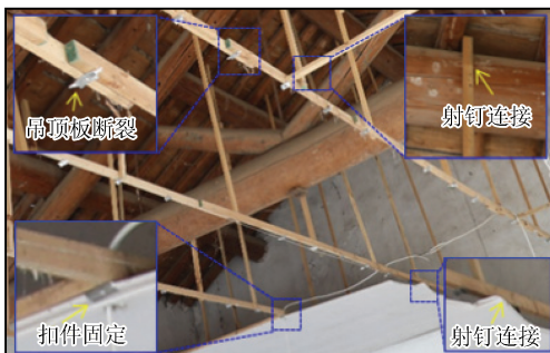
图 13 木龙骨吊顶破坏(柳沟乡, VIII 度)
