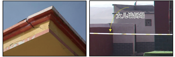
(a) 女儿墙开裂(柳沟乡, VIII 度) (b) 女儿墙坠落(道韩藏族乡, VIII 度)
