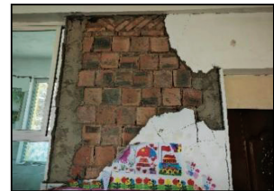
(c) 填充墙构造柱(柳沟乡, VIII 度)
