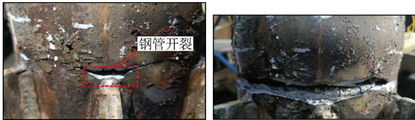
(I) 钢管开裂 (II) 钢管撕裂(混凝土外流) (c) 破坏阶段
