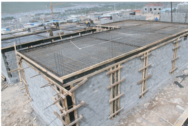
图 3 在建中的砖混结构居民建筑
