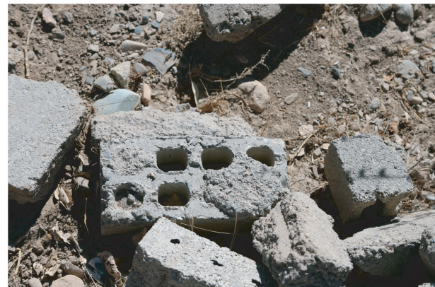
图 4 8 孔砖作为填充砌体
