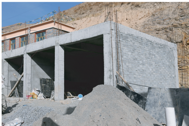
图2 在建中的框架结构居民建筑
