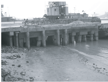
图2 码头桩基现场照片
