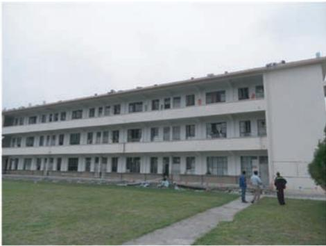
图5 建筑物女儿墙脱落
