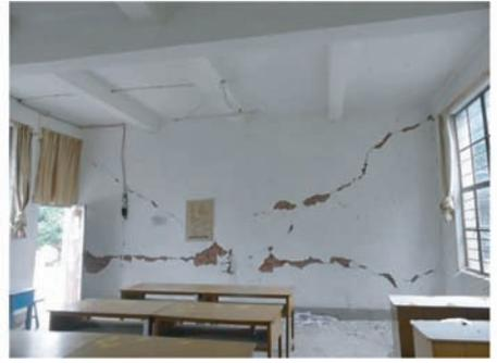
图6 教学楼内墙体X型裂缝
