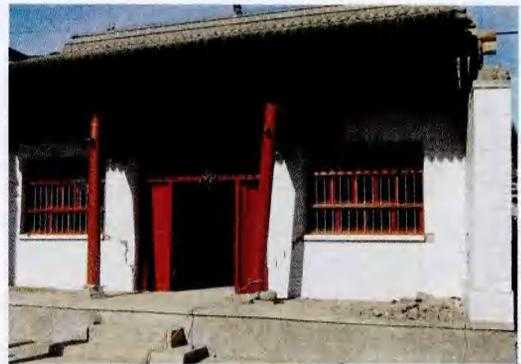
图2 2013年甘肃岷县M<sub>s</sub>6.6地震中砖木农居震害
