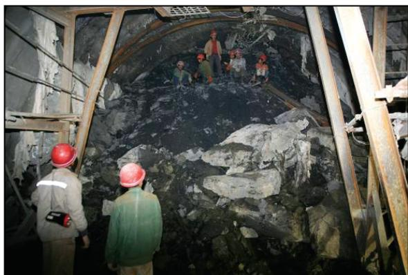
图 1 龙溪隧道黏滑断层段隧道整体垮塌
